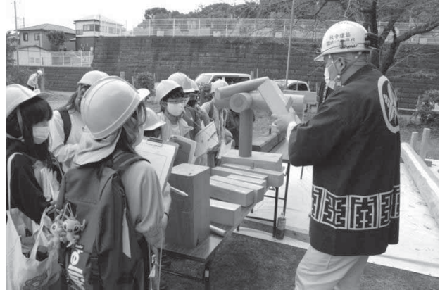
図 16 小学生を対象とした耐震改修工事見学
