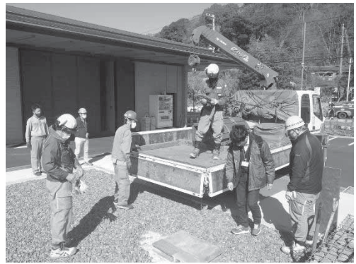
図 19 馬入川鉄橋のレンガの設置の様子
