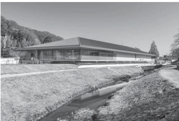
図13 駒寄川護岸整備
