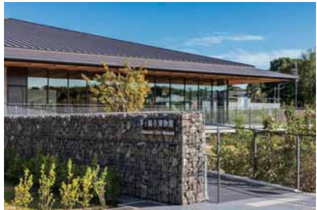
スロープ（西側）
