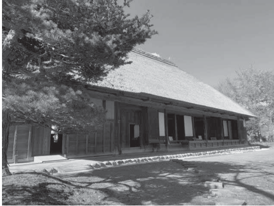
図 15 耐震改修を施した旧和田家住宅
